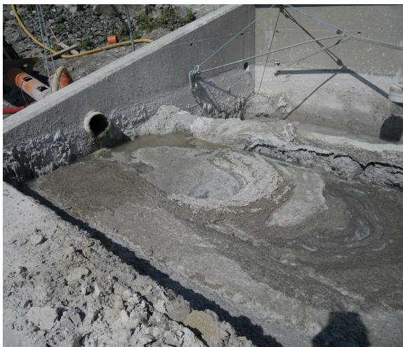
Sedimentasjonsbasseng Foto:Tone Line Fossnes, Miljødirektoratet
