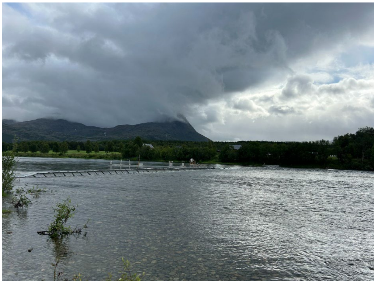
Figur 8.5. På dette bildet ser man at flyteristene over mot motsatt bredd ikke har tilstrekkelig med oppdrift når vannstanden har nådd et visst nivå. Foto: Reisa Elvelag
