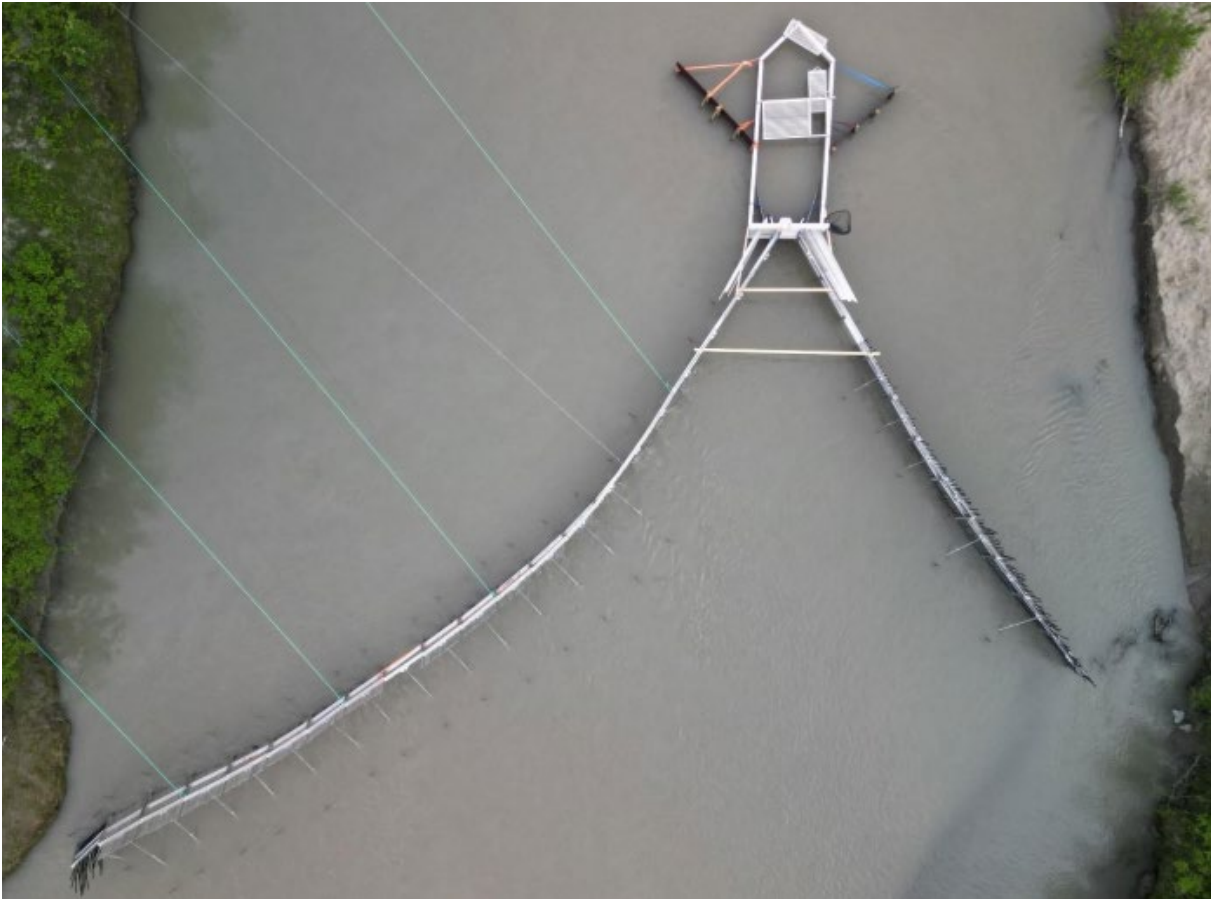
Figur 6.5. I Máskejohka var det åpninger inn mot land for å muliggjøre toveis fiskevandring. Foto: Tanavassdragets fiskeforvaltning
