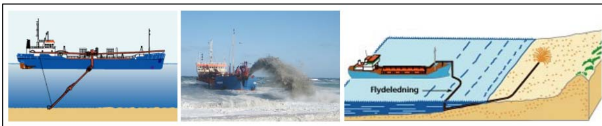
Figur 25. Kunstig tilførsel av sand fra havbunn til innenforliggende sandstrand ved hjelp av sand-dumper. Eksempel fra Danmark (Kystdirektoratet 2015).
