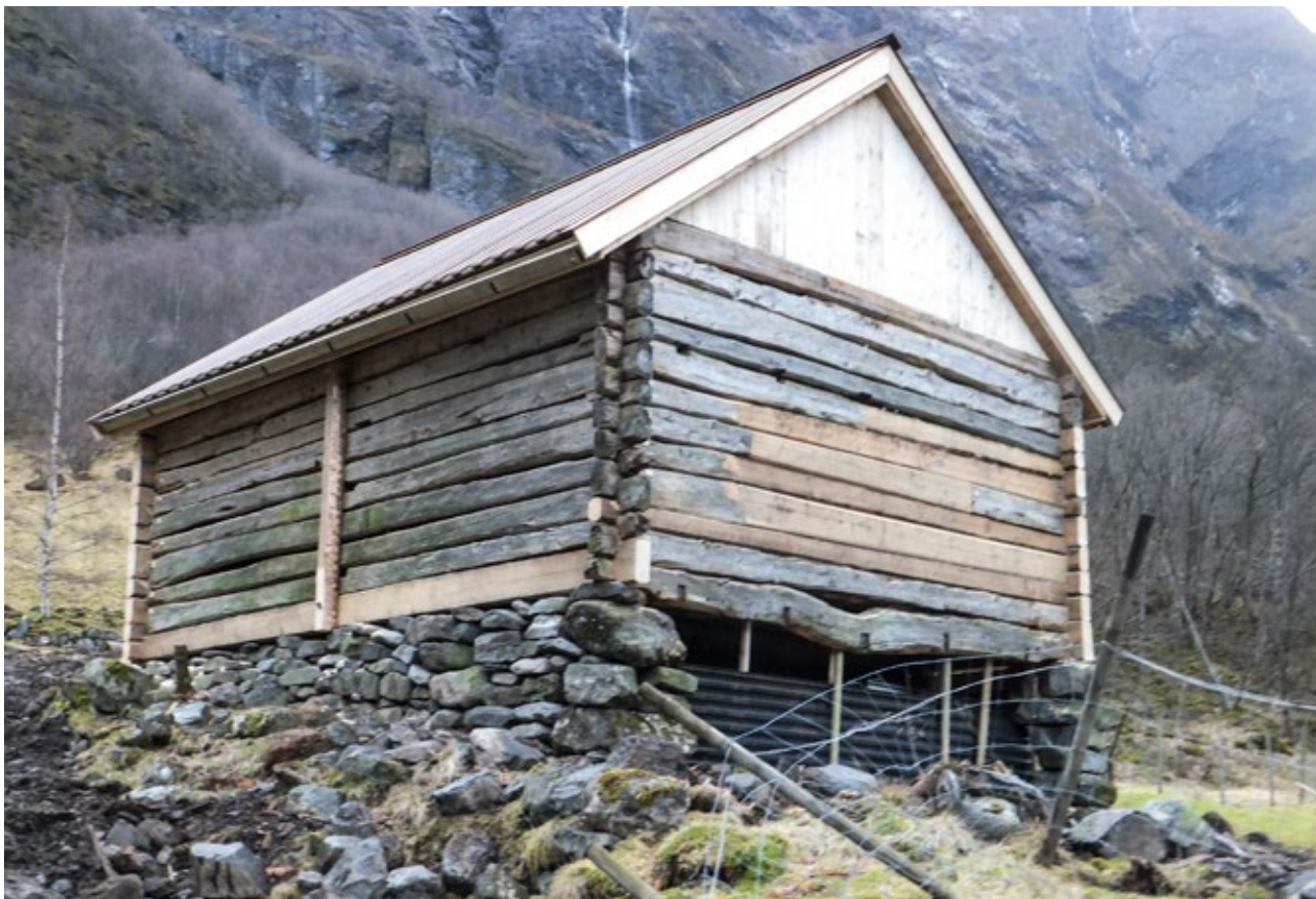
Istandsatt tobakkshus på Styvi i Nærøyfjorden landskapsvernområde. Det meste av tømmeret ble gjenbrukt. Foto: Anbjørg Nornes
