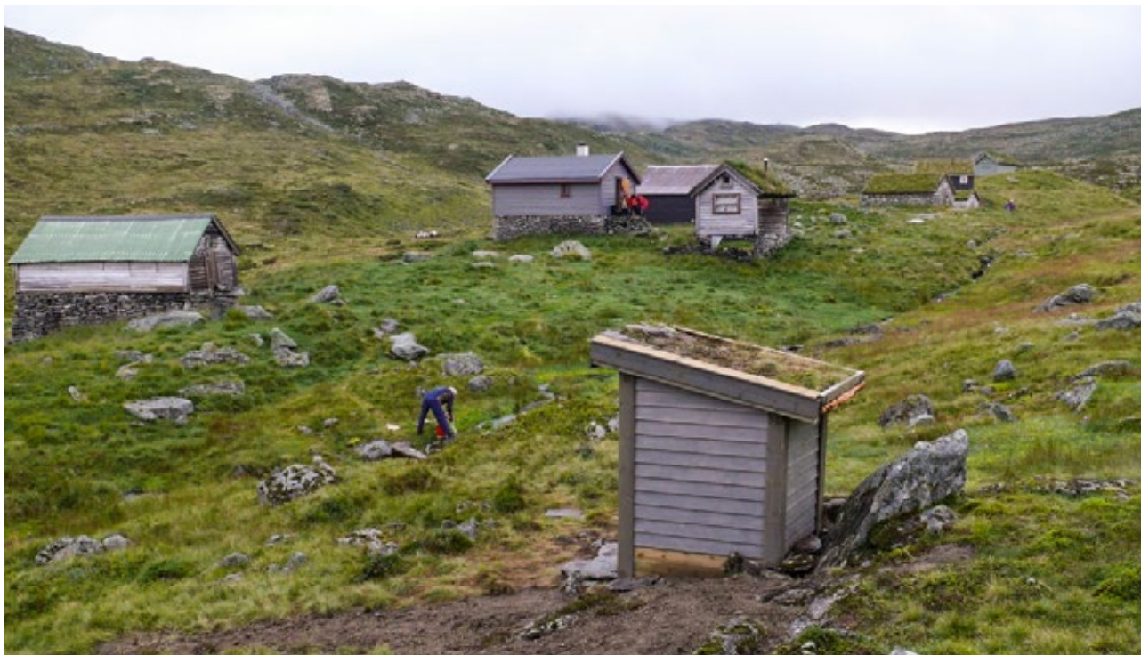
Felles utedo på stølen Vatnane i Stølsheimen landskapsvernområde. Nytt bygg er plassert i utkant av stølen. Foto Nils Kvamme
