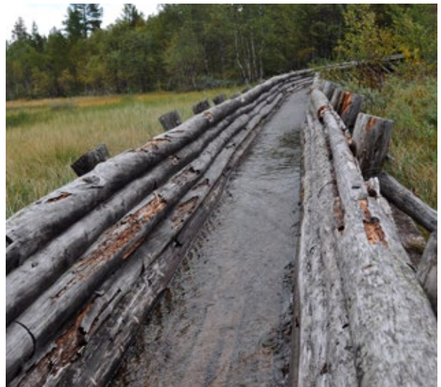
Tømmerrenna mellom Feragen og Langtjønnå i Langtjønnå landskapsvernområde. Renna har råteskader og trenger istandsetting. Foto: Jan Erik Andersen
