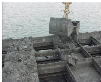
Foto som viser hvordan leirmassene ble lagt ut (Foto: Rijkswaterstaat)
