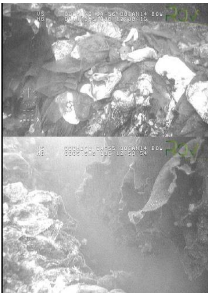
Figur 6: Eksponert avfall i skadet tildekking i Kollevågen (NGI, 2014).
