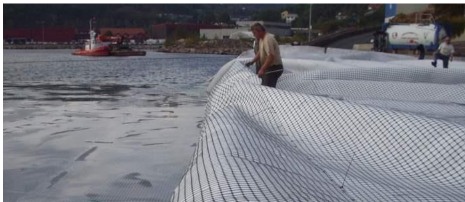
Figur 3: Legging av geotekstilduk ved kaia til Glencore (tidl. Xstrata og Falconbridge) nikkelverk i Kristiansand. Foto: Jon Egil Vinje.
