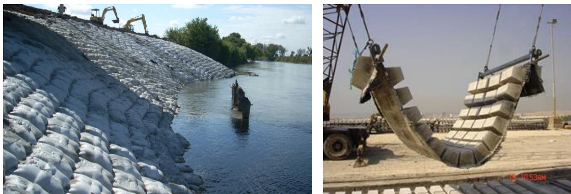
Figur 4: Foto til venstre: Tildekking med betongmadrasser hvor betongen injiseres i lommer i en fiberduk. Foto: http://aspent.com . Foto til høyre: Prefabrikerte betongmadrasser. Foto: http://www.geosynthetica.net .
