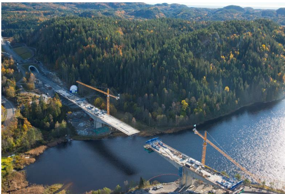
Oppdatert kunnskap om naturverdier i f.eks. Naturbase er nyttig for Jernbaneverket i arbeidet med å ivareta de biologisk viktige områdene. Her fra bygging av Hallevannetbrua på strekningen Farriseidet-Porsgrunn. Foto: Anne M. Storvik.
