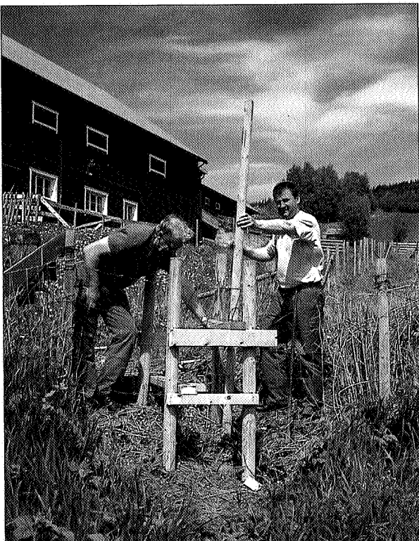
Pilegrimsleden har vært brukt som sysselsettingstiltak i mange kommuner. Her er to karer i gang med å bygge klatrelé ved Vedum gård i Øyer.
