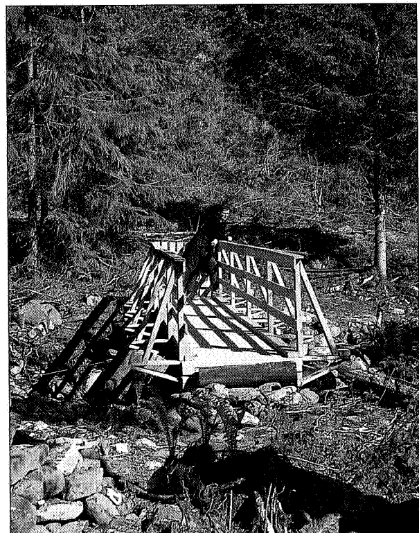
Det er også bygget bruer og klopper, lagt kavlebruer og reist skigarder langs leden. Her ser vi et eksempel på en nybygget bru, også denne i Øyer kommune.
