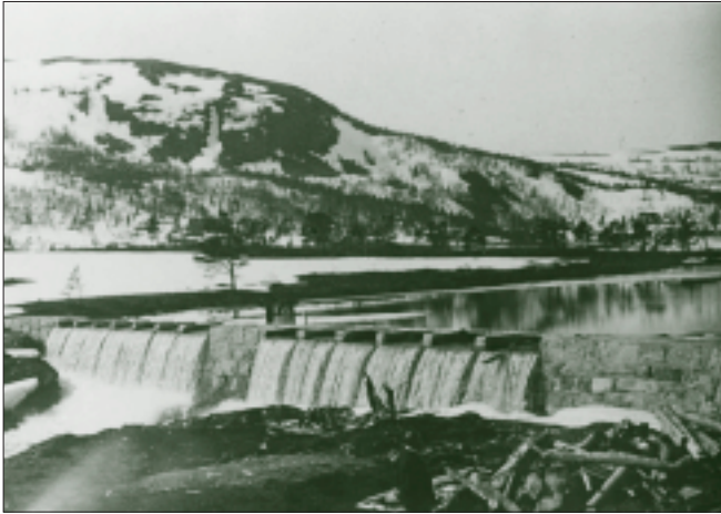
Våvassdammen ble bygd ca 1910. Våvatnet tjener som vannmagasin for Skjennaldfossen kraftstasjon, som ble bygget for drift av Norges første elektriske drevne jernbane - Thamshavnbanen (1908). Fra Våvatnet renner vannet fritt igjennom Sandåa, Songsjøen, Songa til Gangåsvannet.
