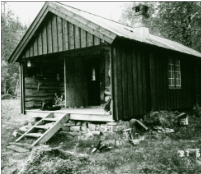
Hjordtalshytta. Foto tatt under befaring av utmarksbebyggelsen i 1997.
