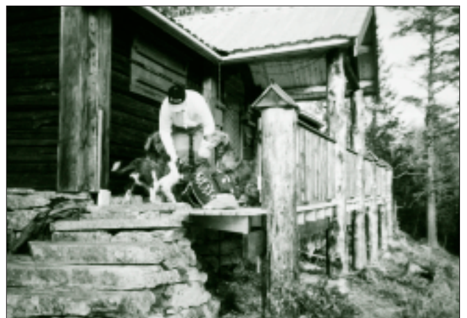
Frontpart av Svarttjønndalshytta med nytt tak og ny veranda. Foto tatt under ferdigbefaring høsten 2002.
