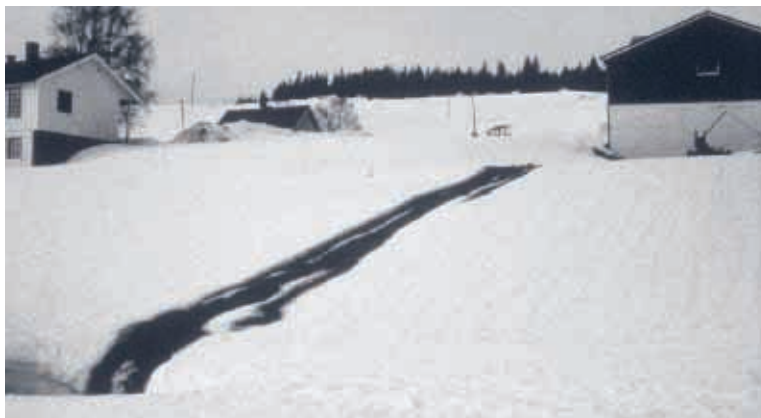
Utette gjødselkjellere ga synlige problemer.
