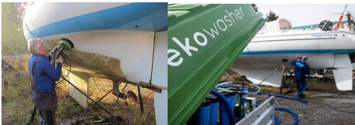
Figur 19: Bilder av mobilt spyle- og renseanlegg ( www.ekowasher.se )
