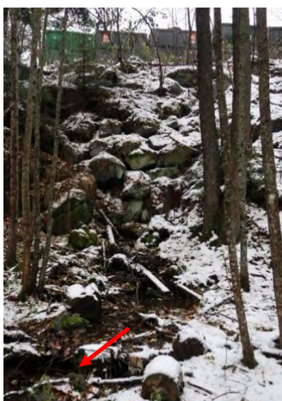
Figur 20. Vann renner ut av skråningen med fyllmasser bestående av stor stein som ligger under lokaliteten. Øverst på bildet kan man se containere fra gjenvinningsstasjonen til kommunen.
