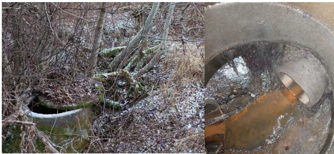
Figur 37. Bilder fra kum nedstrøms utslippspunktet for overvann fra Bahusvegen 26. Det var noe bevegelse i vannet i kummen og vannprøven ble tatt her.
