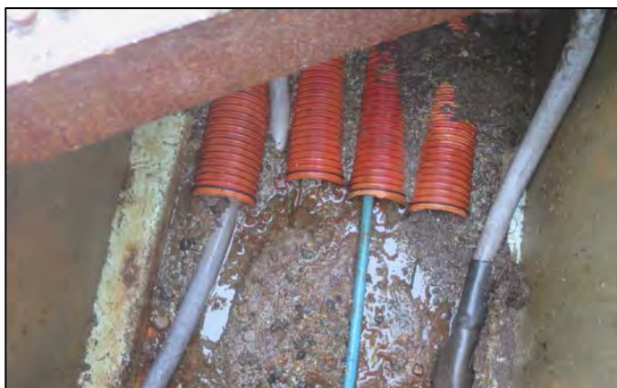
Figur 72. Fotografi av kum ca. 50 meter nord for det nedlagte brannøvingsfeltet på Torp Lufthavn.
