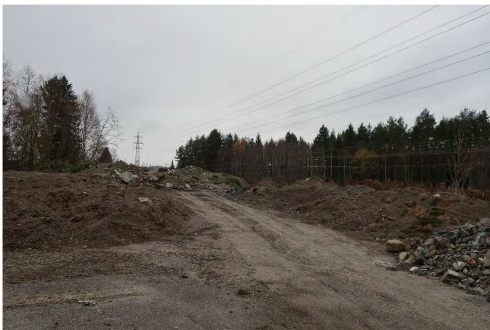
Figur 23. Foto tatt ved befaring 29.oktober 2018. Bildet viser dagens mellomlagring av masser på tidligere brannøvingsområdet.
