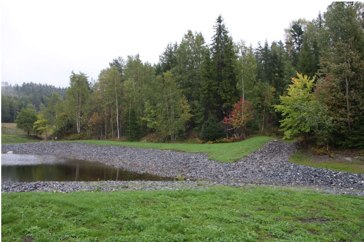
Figur 20 Grønmo Avfallsdeponi. Dammer og terskler i bekken vil fungere som forsinkende/fordrøyende elementer. Foto: Elisabeth Sjødahl
