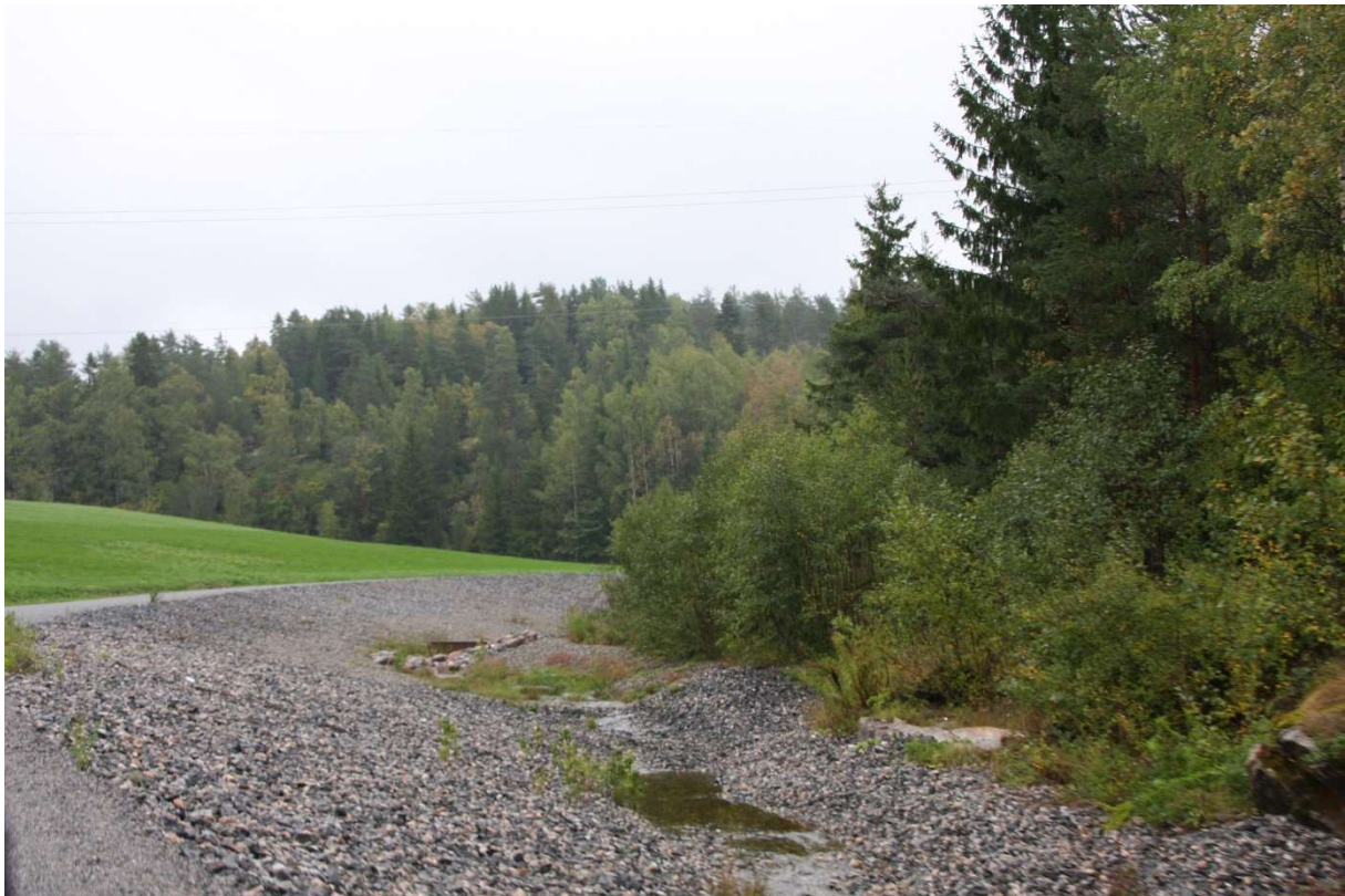
Figur 19 Terrengarrondering og avskjærende grøfter rundt Grønmo Avfallsdeponi. Foto: Elisabeth Sjødahl
