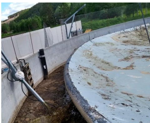
Eks på kum med delvis dekke av duk. Her røres gjødsla opp før spredning. Foto Martha Ebbesvik, NORSØK
