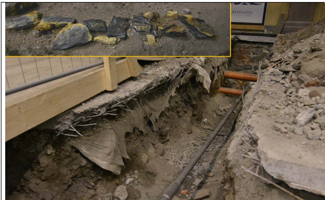
Figur B3 Blandmasser medfører usikkerhet i forhold til karakterisering. Her besto blandmassene av mindre enn 10% Galgebergskifer. Det er ikke her nødvendig å behandle disse massen som forurenset.
