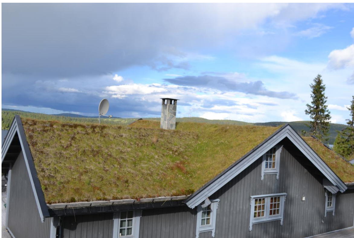
Figur 1. Torvtak basert på Sphagnumtorv som vekstmedium, som uten gjødsling får svært lite grasvekst etter noen år.
