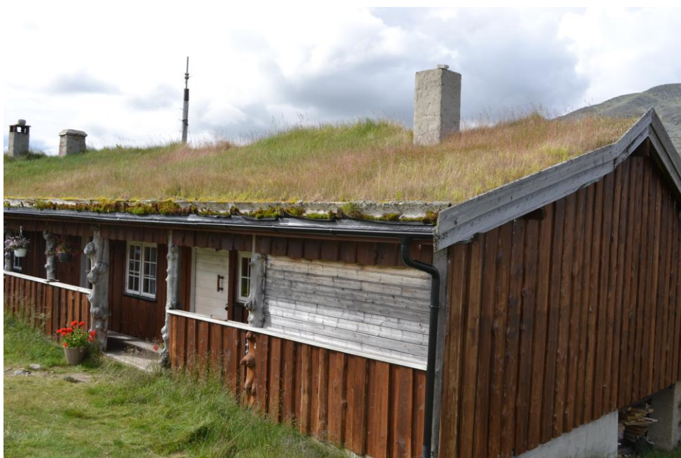
Figur 4. Mineraljordbasert torvtak med nøysom grasvegetasjon av samme arter som vokser på setervollen.
