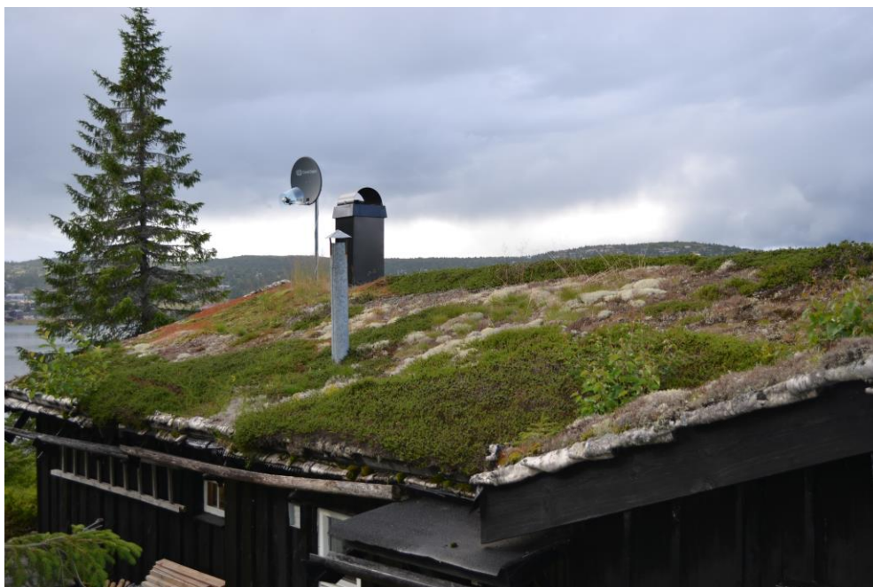
Figur 3. Mineraljordbasert torvtak med vegetasjon av lyng, lav og nøysomme urter som også vokser i området rundt hytta.
