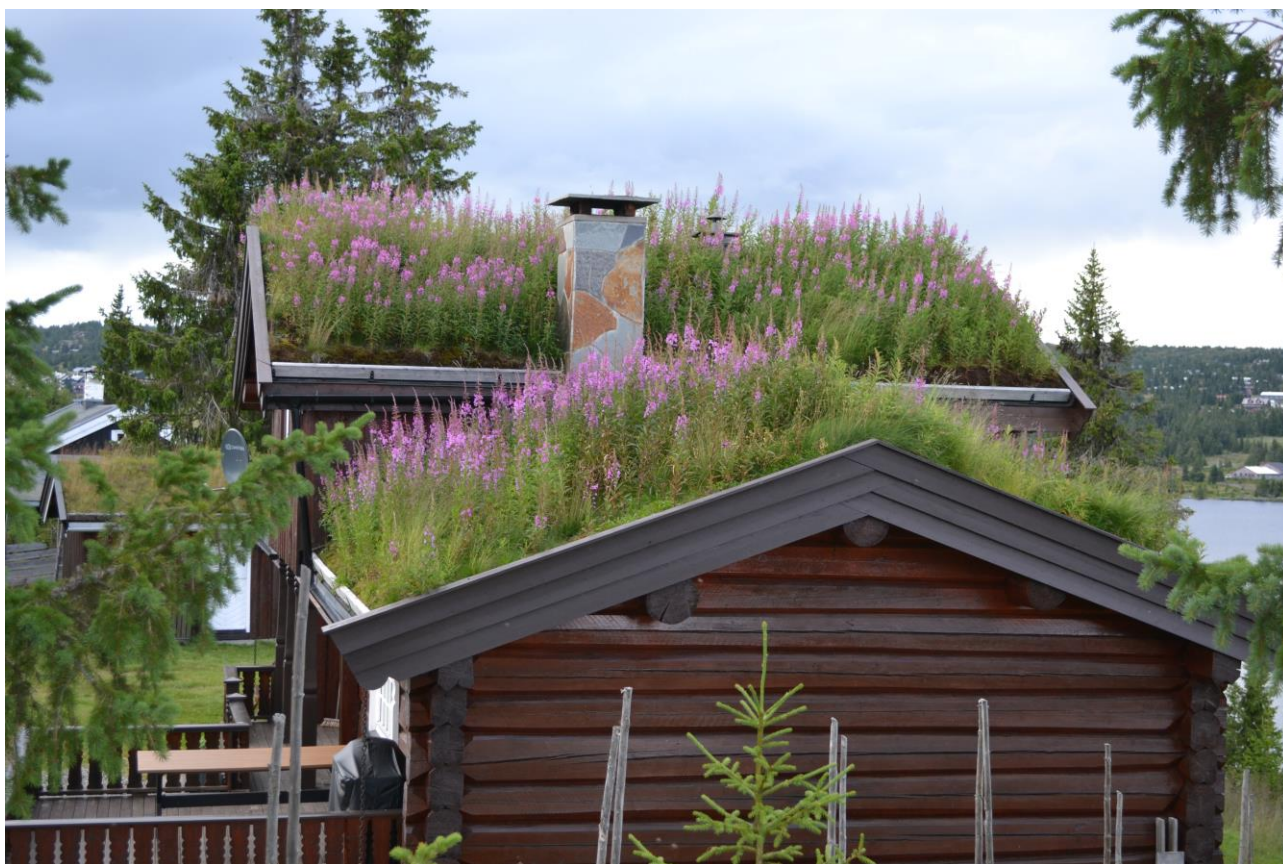
Figur 2. Torvtak dominert av geitrams med dyrkingsmedium av resirkulert organisk avfall.
