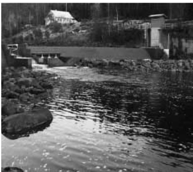
Figur 8.1. Dam Mannflåvann med fisketrappa til venstre i bildet og klappluke for regulering av vannføring til høyre.
