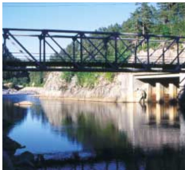
Utløpet fra Laudal kraftstasjon med første del av minstevannføringsstrekningen.
