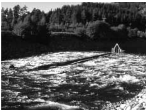
Den nederste terskelen i minste-vannføringsløpet ved Laudal. Laks synes å reagere negativt på å komme opp i et minste-vannføringsløp med mye lavere vannføring enn i elva de opprinnelig vandret opp i.
