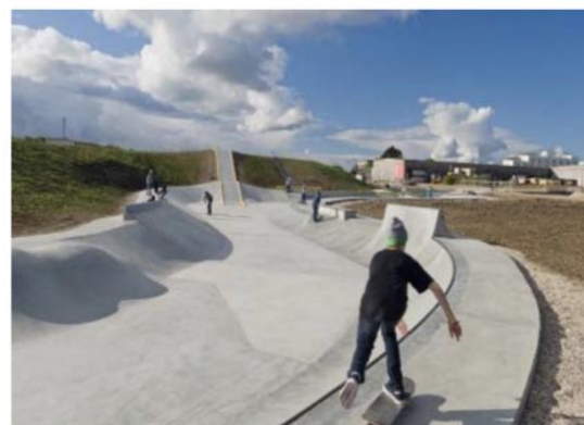
Skateanlegg i Roskilde med flerbruksfunksjon som flomvei og fordøyningsbasseng (foto: Søren N. Enevoldsen, Sne Architects og Rune Johansen).
