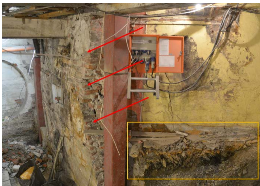
Figur 3 Eksempel på skader på bygningskonstruksjoner som følge av forvitring av alunskifer. Veggen presses ut pga. svelletrykk fra forvitrende alunskifer (røde piler). Veggen er fundamentert direkte på og etablert inn mot alunskifer og står i fare for å rase ut pga. setninger. Foto: Erik Endre
