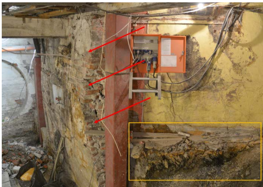
Figur 4 Eksempel på skader på bygningskonstruksjoner som følge av forvitring av alunskifer. Veggen presses ut pga. svelletrykk fra forvitrende alunskifer (røde piler). Veggen er fundamentert direkte på alunskifer og står i fare for å rase ut pga. setninger.
