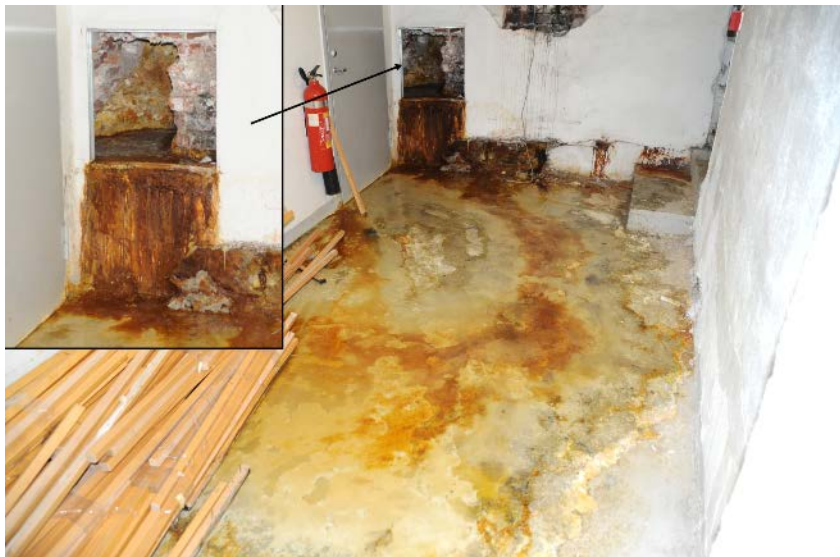
Figur 2 Innlekkasje av surt vann (pH < 3) i et kjellerrom. Vannet kan medføre skade på
