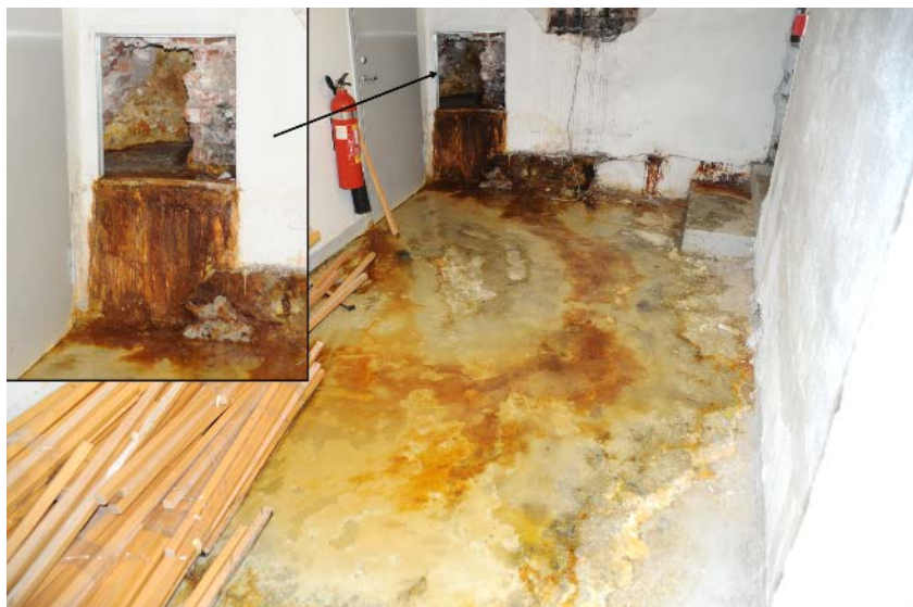
Figur 3 Innlekkasje av svært surt vann (pH < 3) i et kjellerrom. Kontakt med vannet kan medføre fare for etseskader på huden og på fottøyet
