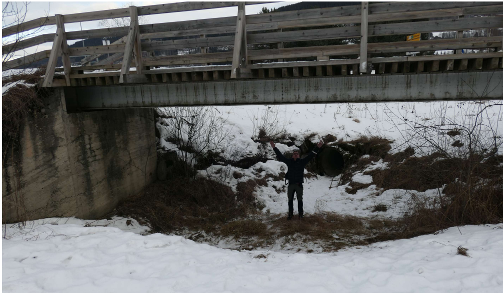
Gangbru over avsnørt Veslegausa
