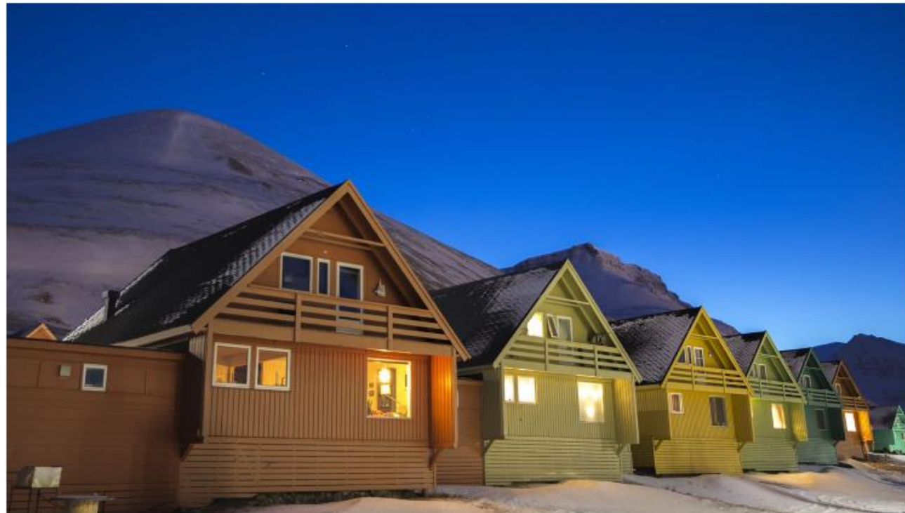
Den gamle måten å fundamentere bygg på på Svalbard er ikke god nok, etterhvert som klimaet endrer seg. (Foto: Ekseth, Ivar/Scanpix)
